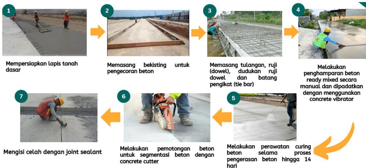
Gambar 7. 1 Metode Pelaksanaan Pengecoran Beton untuk Rigid Pavement
